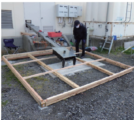
▲写真② DIYによるサイロ設置
