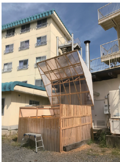
▲写真③ DIY仮完成運用中のサイロ (富士大学学生寮)
