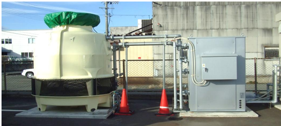
冷温水機設置写真
